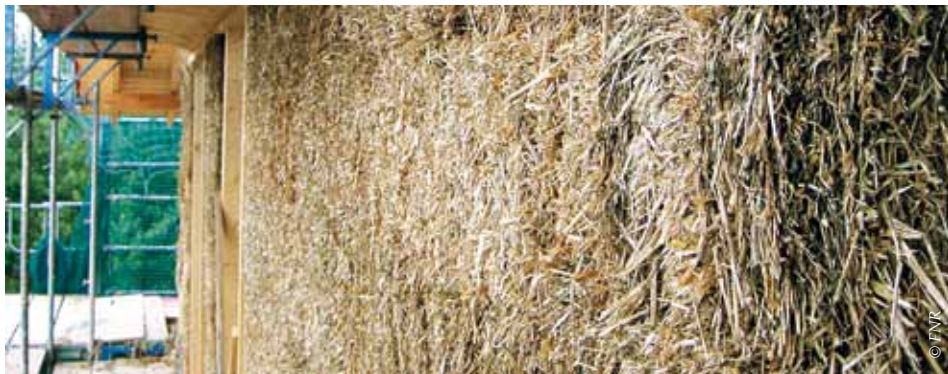
Bei fachgerechter Herstellung und Einbau sind Baustrohballen auch sicher vor Schädlings- und Schimmelbefall.
