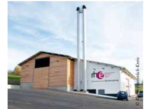
Heizanlage Schulzentrum Füllkasten, Simmern
